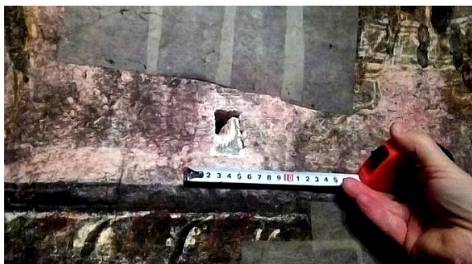
Fig. 3.3. Vedere stratigrafică a celor două fresce prin carotaj
