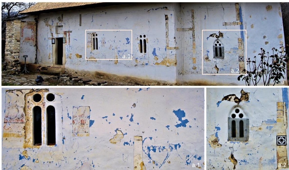
Fig. 3.10. Biserica Sf. Arhangheli (1495), din Cicău, Județul Alba: a.1 și a.2. Detalii cu intervenții inadecvate și semne de vandalism [ Spiridon et al., 2017 ]
